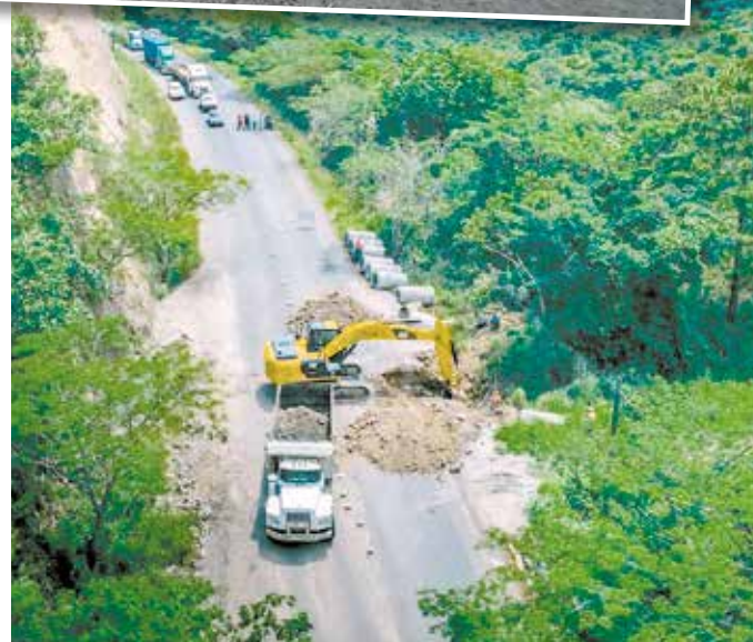
La maquinaria avanza con la pavimentación en esta importante vía de mucha producción en el país.
